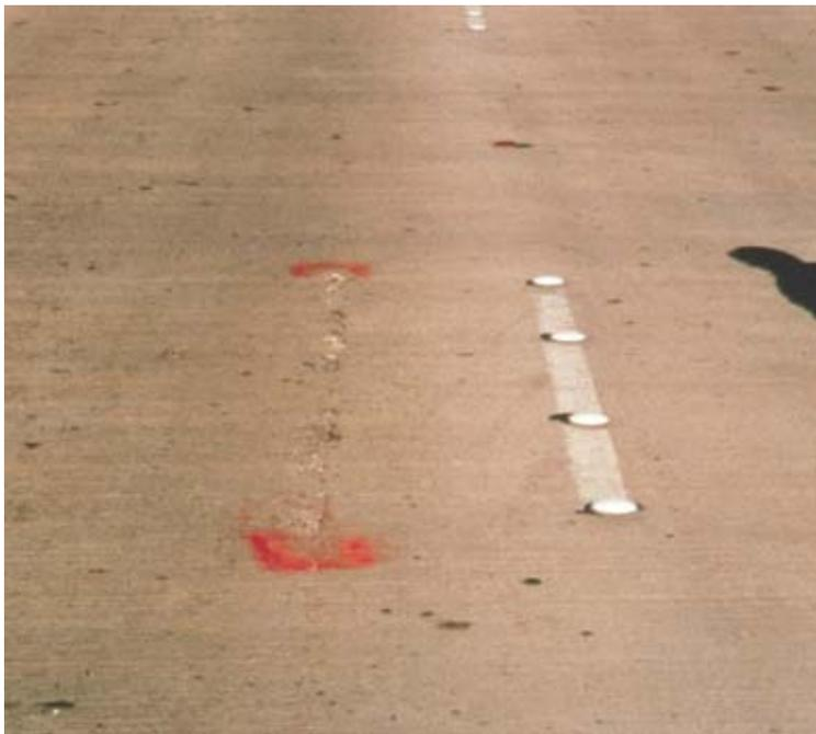
Fig. 8 Large Longitudinal Crack at Panel Edge
