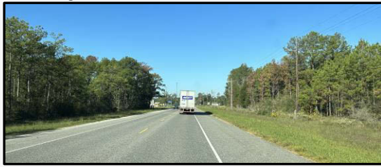
Esta foto muestra la carretera SH 105 existente que consta de dos carriles de circulación de 12 pies de ancho.
