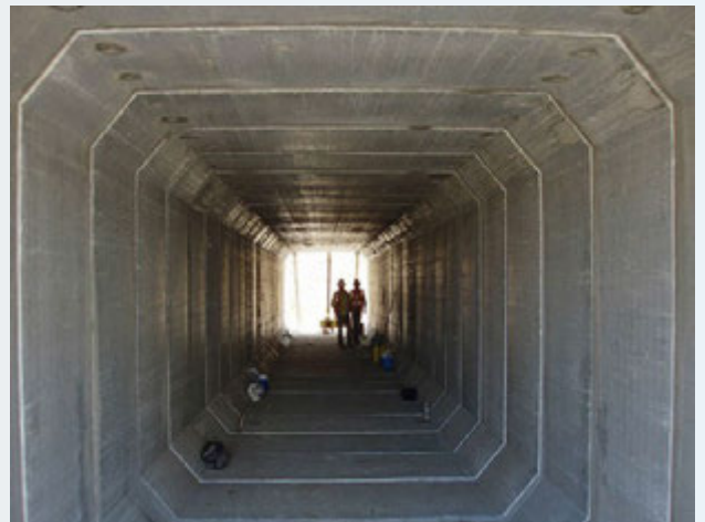
La sustitución de las viejas tuberías de drenaje bajo la autopista por alcantarillas de 12 x 12 pies aumentará considerablemente la capacidad de retención de las aguas pluviales bajo tierra y fuera de las calles.
